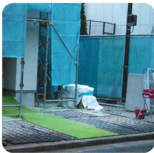
戸建住宅現場
