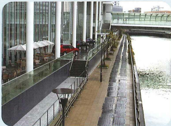
インターロッキング養生
